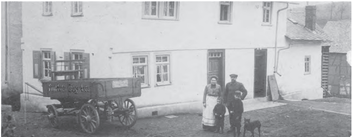
oben: Der "Stammsitz" der Brauerei Raab "In der Eck", heute Blumenweg 3. Rechts hinten der Gebäudeteil mit den Braueinrichtungen. Die Aufschrift auf dem Wagen lautet: „Frankfurter Bürgerbräu“. Auffallend die zwei Türen: links der Eingang der Wohnräume, rechts lagen die Geschäftsräume.
